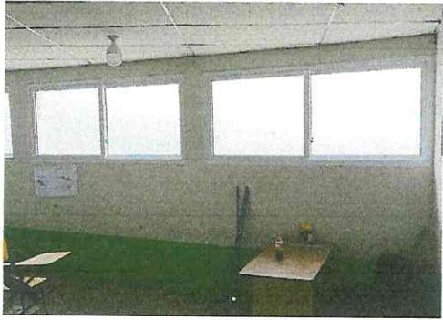
Foto 1: Sustitución de ventanas de metal por ventanas de PVC.
